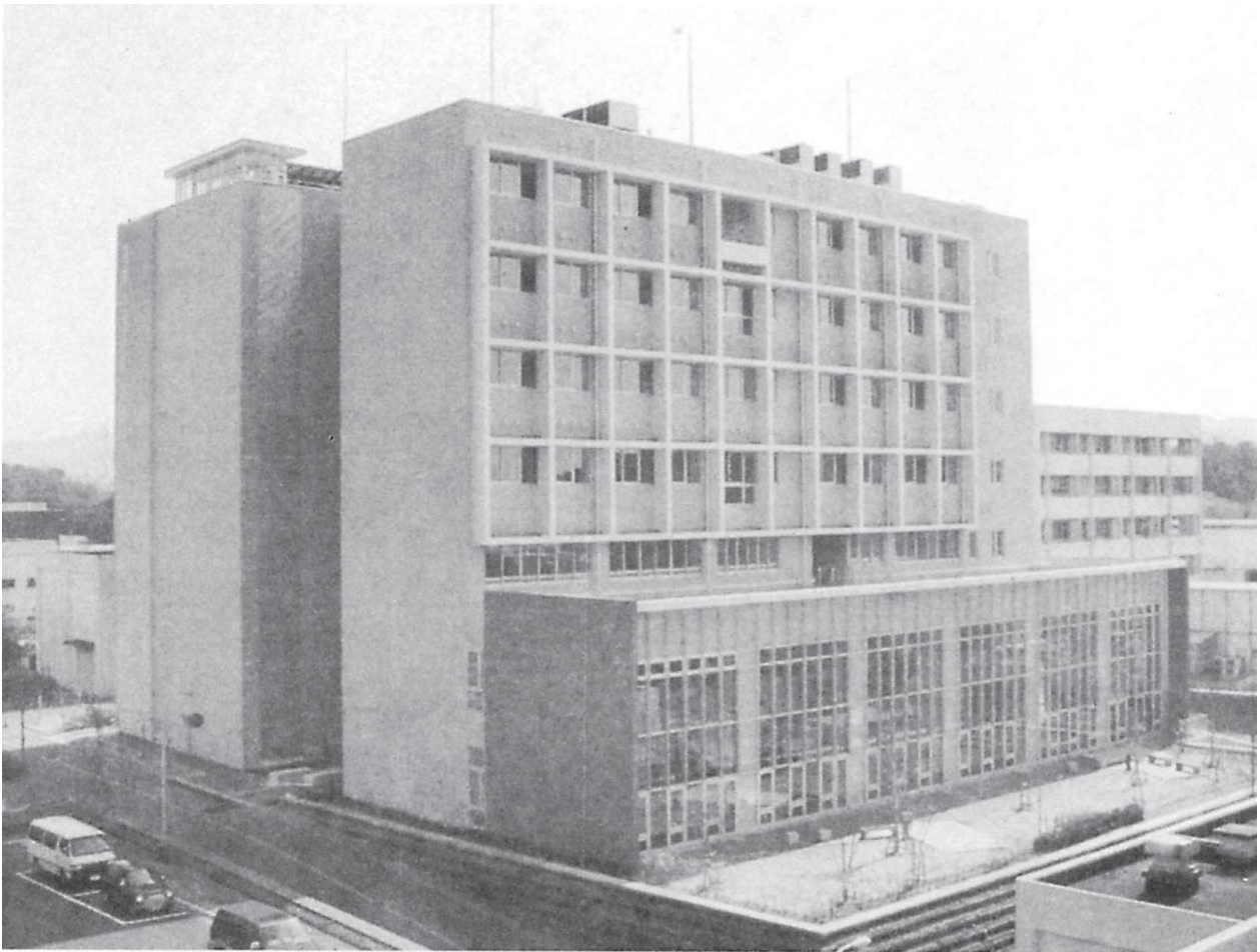
筑紫図書館・総合研究棟
